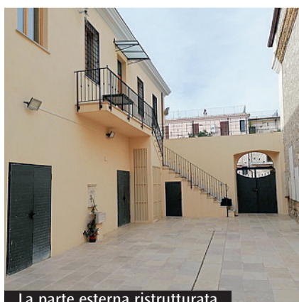
La parte esterna ristrutturata
