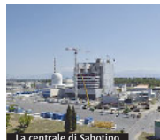
La centrale di Sabotino
